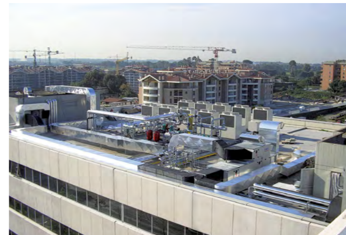
Замена чиллера. Подача холодной воды к фанкойлам.
