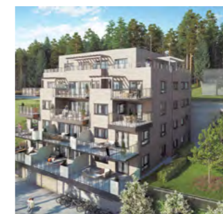
Новый кондоминиум Berges Terasse Complex Драммен, Норвегия ECOi /Aquaera
